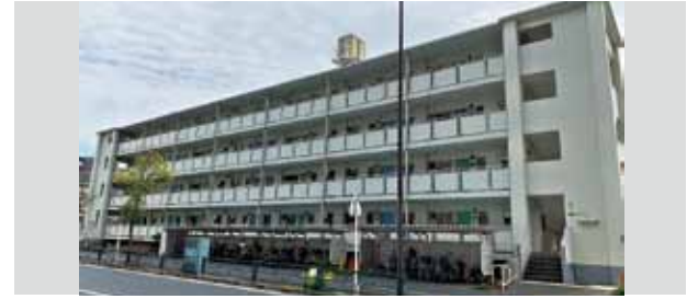
▲写真は区営東砂八丁目住宅
