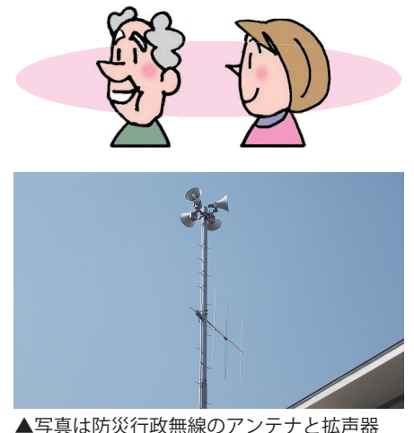
▲写真は防災行政無線のアンテナと拡声器
